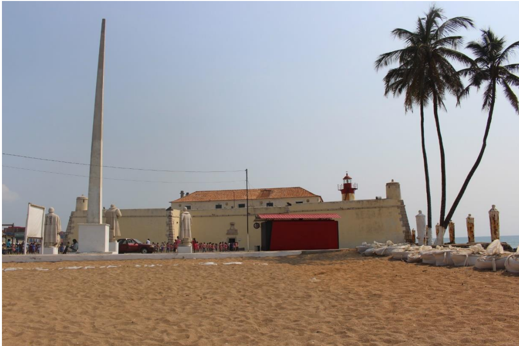
Figura 4-1: Vista da Fortaleza de S. Jerónimo ao longo da orla costeira da Cidade de S. Tomé
