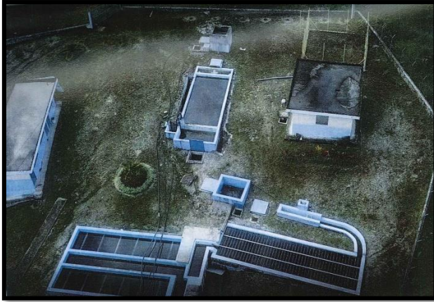
Foto 2. Planta de tratamiento de agua potable de Palanda.
