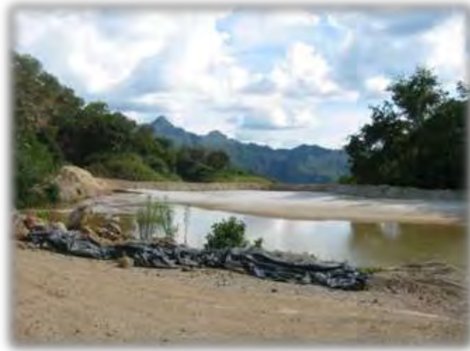
Figura 80. Presa de jales anexa a la Planta “El Coco”
