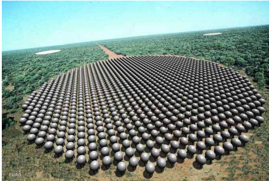
4. kép: Luneberg antenna hálózattól álló rádióteleszkóp terve Ausztráliában (számítógépes grafika, [137])
